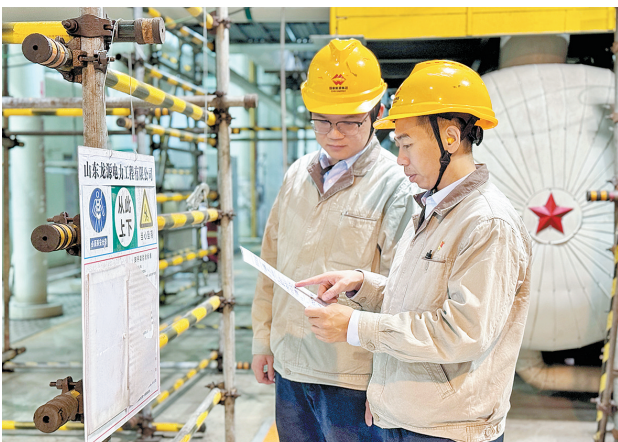
泉州热电巡检员检查现场安全措施。
