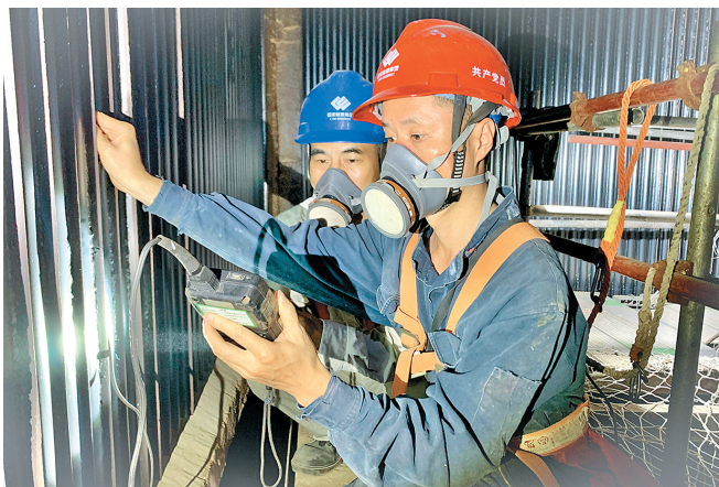
龙岩公司锅炉工检测锅炉水冷壁管厚度。
