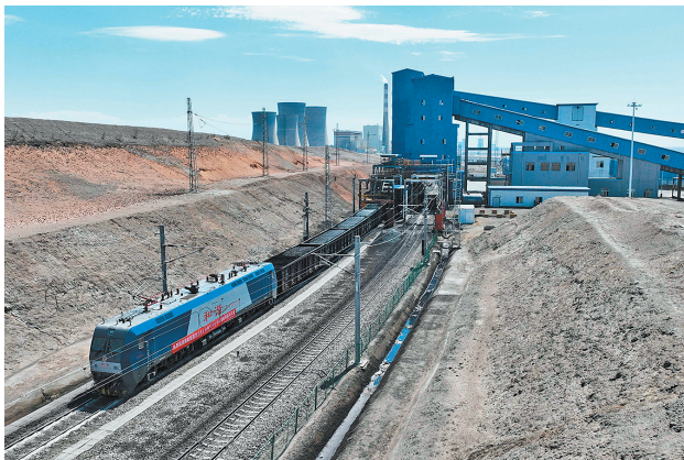
准东露天矿快速装车站首列电力机车投运现场。
