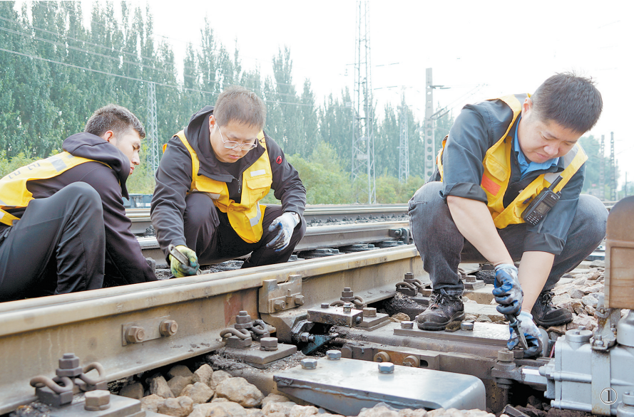
①朔黄铁路原平分公司南电务班组成员调整原平南站13号道岔主机定位表示缺口。
