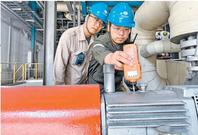
▲国庆前夕,宁夏煤业煤制油公司压实安全责任,强化现场管控。岗位职工深入一线,对各类设备测温测振,巡检工况,监控工艺参数,排查隐患,保障煤制油装置安全稳定清洁运行,全力做好国庆假期期间能源保供工作。图为7月26日,岗位职工开展烧嘴系测温测振作业。本报通讯员 李艳爽 摄
