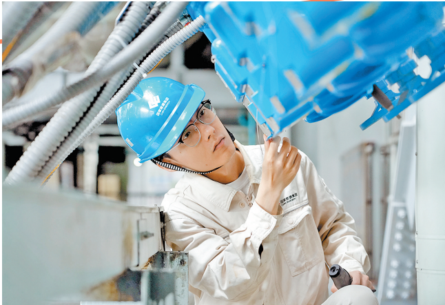
▲临近国庆,广西北海公司压实各级责任,加强机组巡视巡检,排查隐患,及时消缺,统筹燃料储备、应急物资和值班值守,完善应急措施,保障机组安全运行和电力可靠供应。图为9月28日,检修人员在锅炉区域检查水冷壁出口集箱疏水电动门运行状态。本报通讯员 王懋霖 摄
