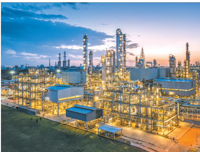
乙二醇装置生产现场。
