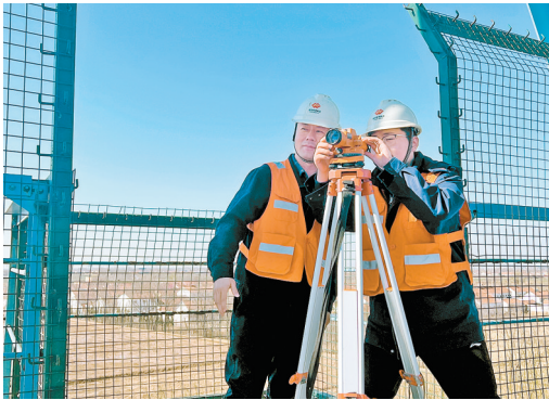
王鹏(左)指导梁晔(右)进行钢桁梁桥上拱度测试作业。
