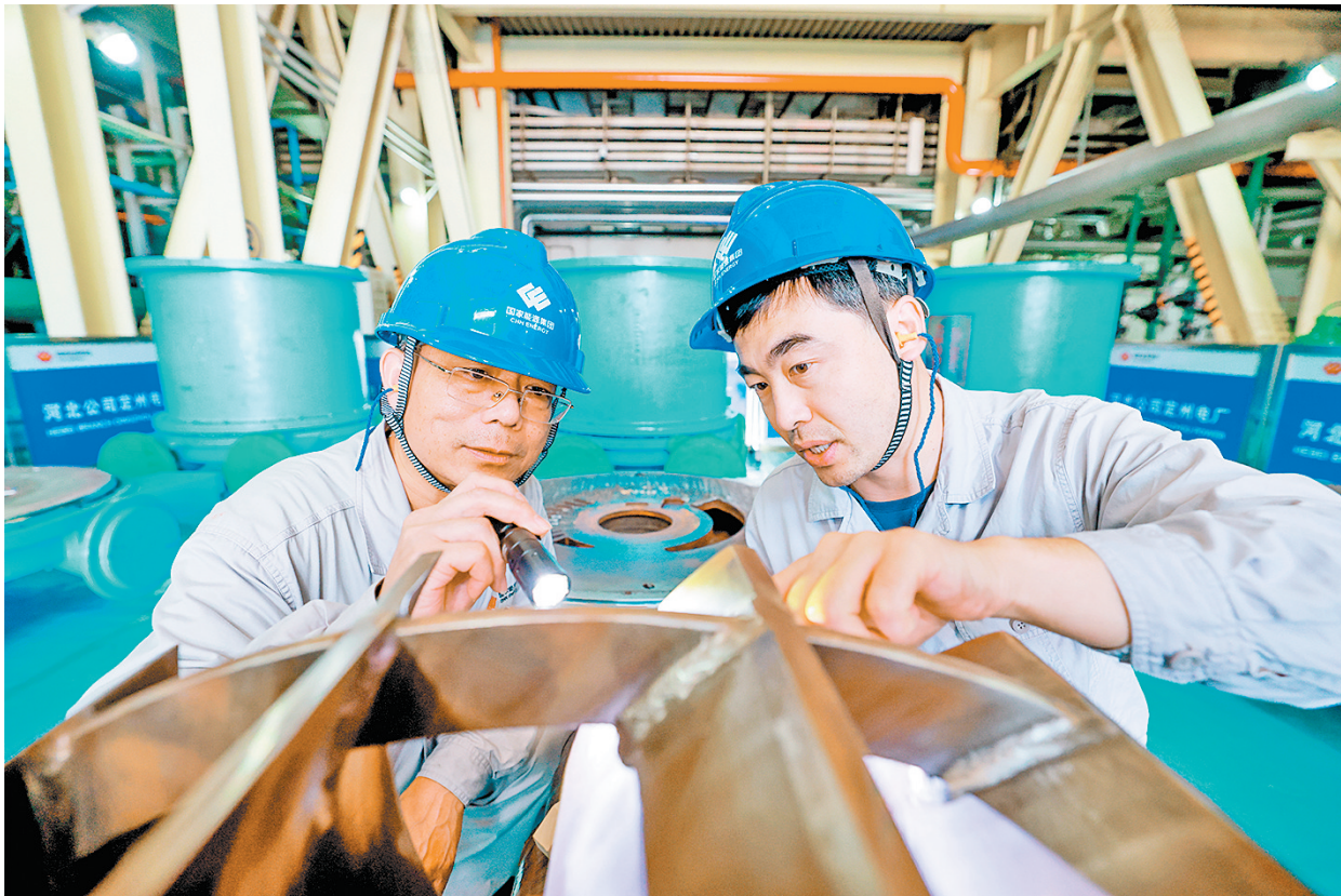
9月1日,河北定州电厂4号机组B+级检修全面启动。检修期间,该厂严控施工进度,从严落实“两票三制”,强化高风险作业安全管控,全力消除设备隐患。图为检修人员对解体后的水环式真空泵转子进行检查。
