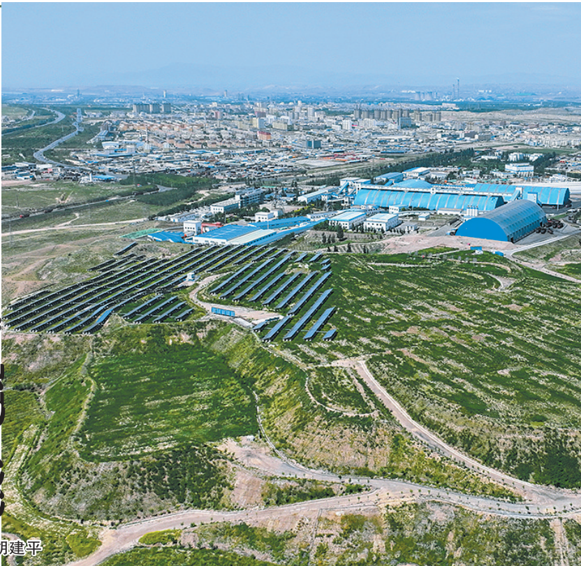
大图 乌海能源利民公司渣堆生态治理现场俯瞰图。 小图 职工查看渣堆治理现场花草长势。
