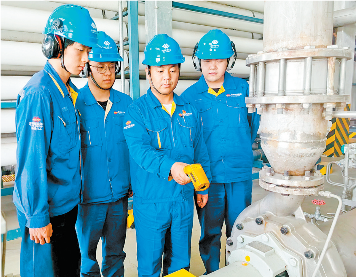
连日来,新疆化工组织新职工走进生产现场,开展沉浸式设备巡检专项培训,帮助青年职工提升岗位技能。专业管理人员详细讲解设备结构、运行原理及巡检要点,以“看得见、摸得着”的方式推动抽象理论向操作实践有效转化。图为8月21日,该公司化学水专业管理人员(左三)为青年职工讲解巡检要点。 本报特约记者 冯永强 摄
