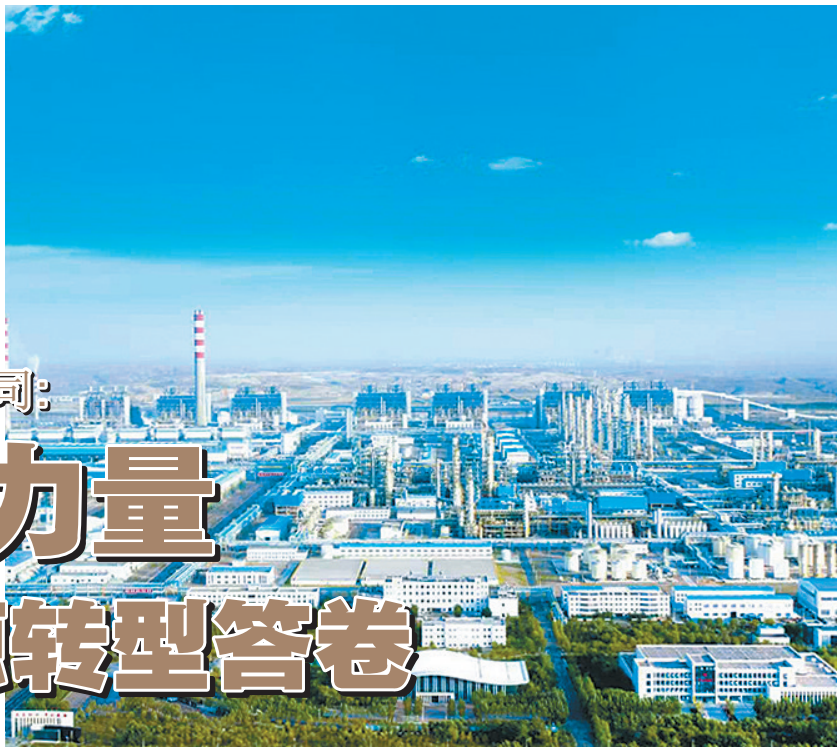
大图:煤制油装置全景。 小图:科研人员持续推进新产品、新工艺的研发。
