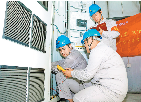
党员突击队检查电源控制柜合闸接触器控制回路接线。
