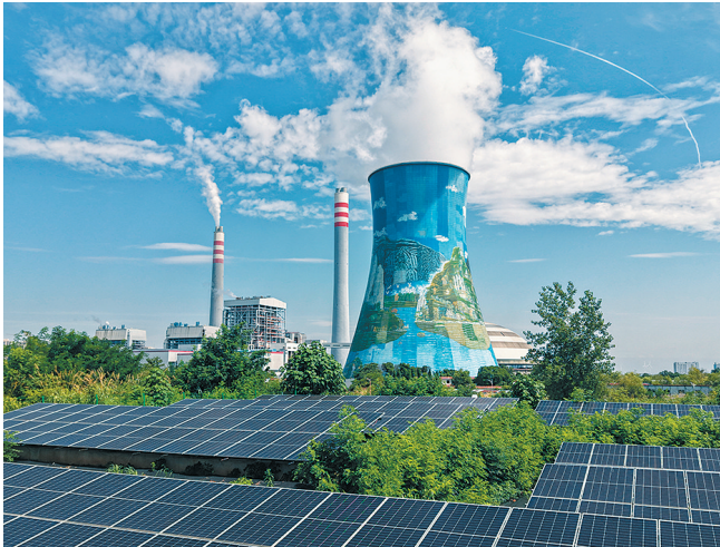
九江公司厂区风貌。
