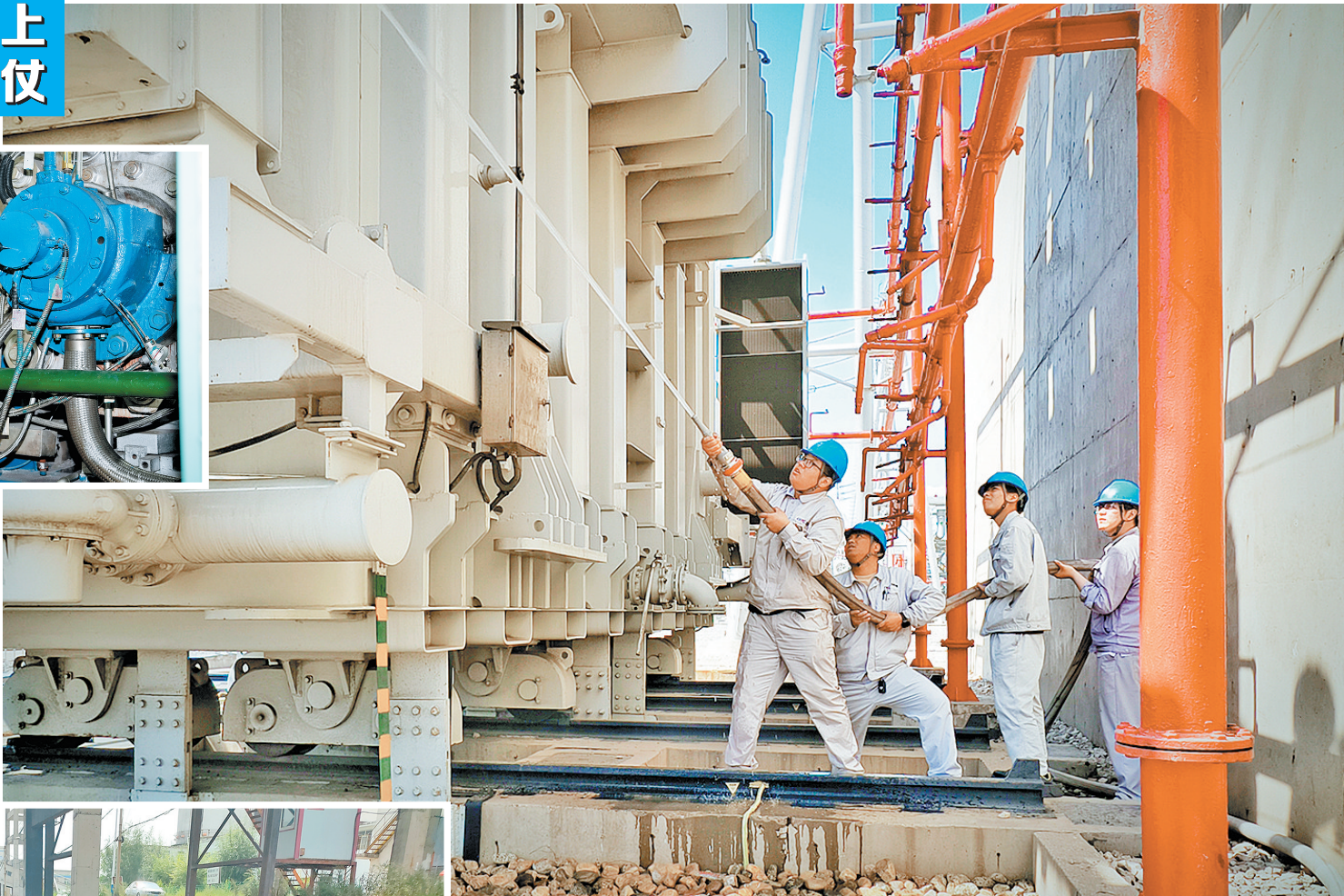
↑7月23日，河北公司沧东电厂维护人员用水冲洗主变压器冷却器。该厂全力落实防暑度夏措施要求，及时为设备做好“防暑降温”，持续提高设备健康运行水平。结合历年来防暑度夏工作中的薄弱环节，对高温、高负荷转动设备的轴承、电机及冷却系统温度加强巡检，对设备开展季节性隐患排查，切实避免季节性事故发生。
