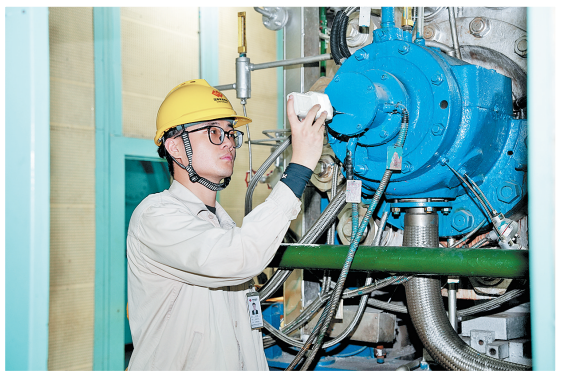
↑7月15日，山东石横公司运行人员对汽泵组轴承进行振动测量。面对持续高温天气，该公司严密监视重点设备运行状态，加强缺陷易发设备巡检频次，确保安全生产稳定。
