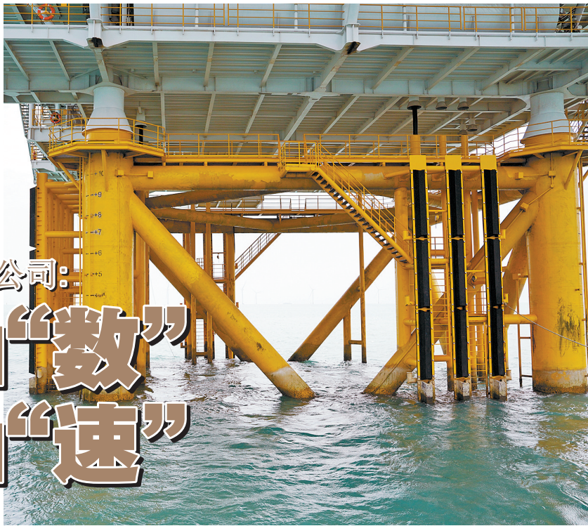
大图:“国能海测1号”水下机器人对龙源电力海南东方升压站进行检测。 小图:龙源电力生产运营指挥中心工作人员开展数据分析统计工作。
