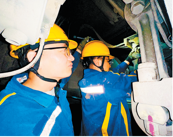
检修小组人员拆解电气线路。
