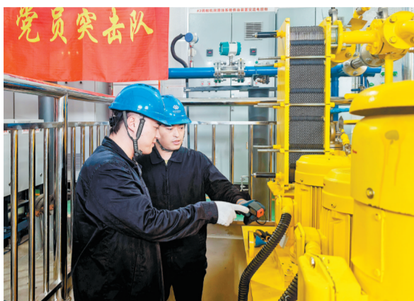
党员检查油气系统运行情况。
