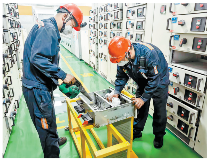
为保障夏季高温时段设备安全运转，神东煤炭洗选中心补连塔选煤厂开展配电室专项除尘保养工作，工作人员严格按照操作流程，对各配电室高低压配电柜、变压器、接线端子等关键设备进行全方位清洁，有效改善了电气设备运行环境，提升了设备散热效率与运行稳定性。图为6月30日，职工为低压配电室配电柜深度除尘。
