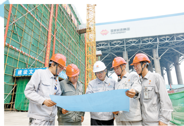
供热临时联合党支部工作人员讨论供热改造施工方案。
