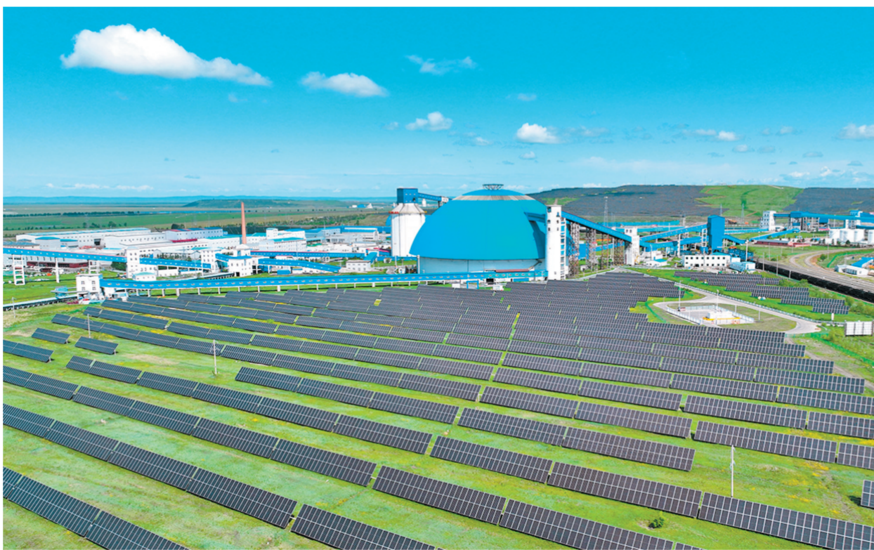
截至6月30日,雁宝能源光伏项目年发电量累计达4689.65万千瓦时,全部用于厂区自用,相当于节约标准煤约1.4万吨,减排二氧化碳约3.56万吨,为企业绿色低碳发展赋能助力。今年以来,该公司严格落实光伏设备精细化运维管理,常态化开展全覆盖、无死角巡检,定期完成设备常规养护,全力保障电站光伏项目稳定运行。图为宝日希勒矿区日内自发自用光伏阵列(摄于6月30日,无人机照片)。
