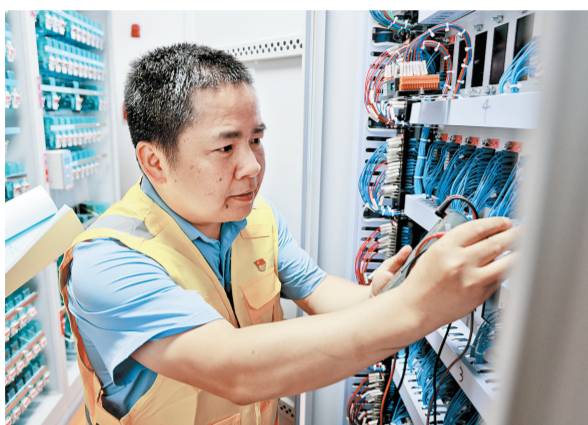
龙鹏在信号机械室测量继电器电压。
