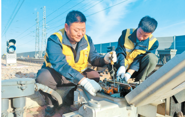
晓健(左)与同事一起调试道岔转辙机。 朔黄铁路神池南电务工队信号工宋
