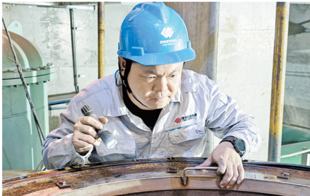
修工赵进检查凝泵入口滤网。 河北沧东电厂维护部汽机辅机班检
