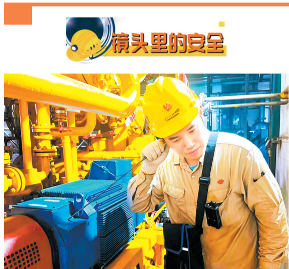
↑ 为抓实抓细迎峰度夏各项工作部署，安徽公司马鞍山电厂层层压实设备管理责任，全面提升隐患排查治理、应急处置综合能力，确保机组高温大负荷期间稳定运行。图为6月24日运行人员借助听棒检查泵体运行状态。 本报通讯员 戴竹苗 陈汪生 摄
