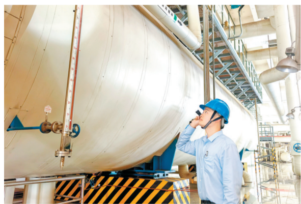
↑ 为抓实抓细迎峰度夏各项工作部署，安徽公司马鞍山电厂层层压实设备管理责任，全面提升隐患排查治理、应急处置综合能力，确保机组高温大负荷期间稳定运行。图为6月24日运行人员借助听棒检查泵体运行状态。 本报通讯员 戴竹苗 陈汪生 摄
