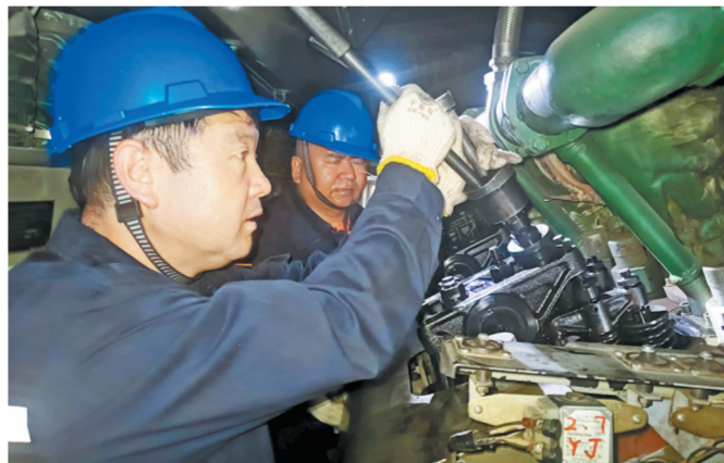
车间职工更换内燃机机油喷油器。西部创业宁东铁路驾鸯湖车站检修
