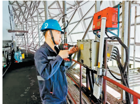
↑ 进入安全生产月,雁宝能源储运中心以常态排查、精准整改、规范应急为抓手,将精细化、智能化安全管控贯穿储装、运输、配、值守全流程,持续筑牢安全生产防线,保障现场作业安全有序。图为6月2日,职工检查设备在线监测装置分线箱。本报通讯员 胡洪厚 姜洋 摄
