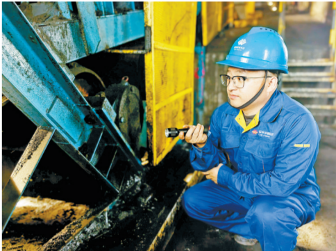
↑ 近期,新疆化工组织开展全覆盖、无死角、高频次隐患排查整治工作,逐一核查装置运行状态及工艺管线、消防设施等关键点,并严格执行销号管理,全力保障生产装置安全稳定运行。图为6月5日,职工检查输煤系统运行情况。本报特约记者 冯永强 通讯员 刘武 摄
