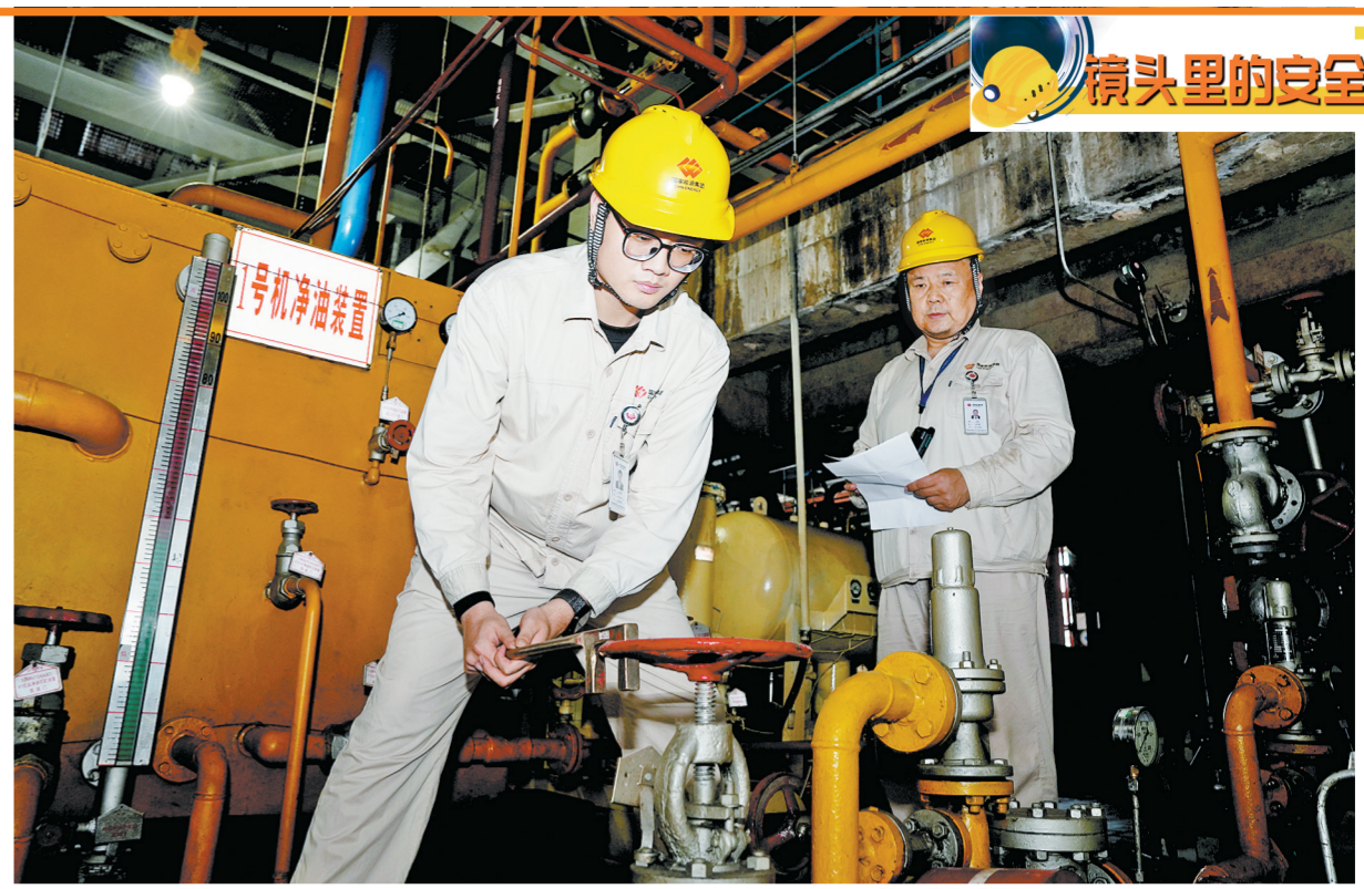
↑ 为扎实做好迎峰度夏电力保供工作,山东石横公司从抓好设备管理、针对重点区域、重点岗位、关键环节深入开展风险研判,不断加大安全供电保障,确保各类供电设施安全、稳定、高效运行。图为6月3日,运行人员执行大机净油输送泵隔离操作。本报记者 高珊 摄
