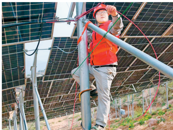
突击队员樊文伟进行电气线路接线作业。
