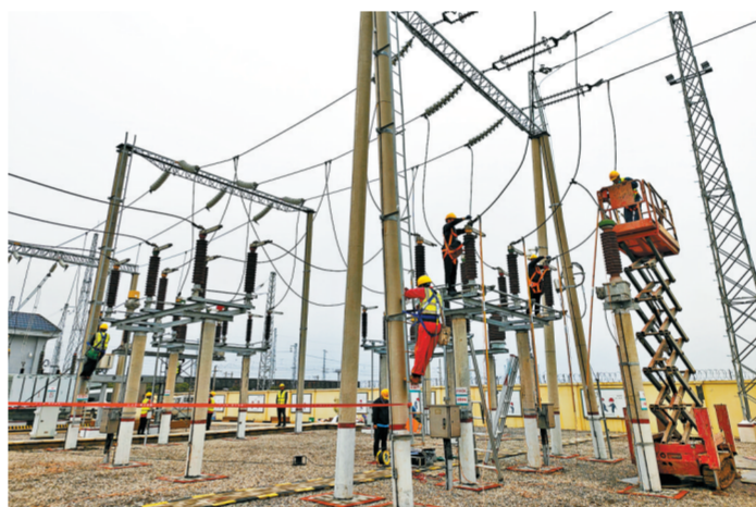
作业人员检修二一千伏供电设备。
