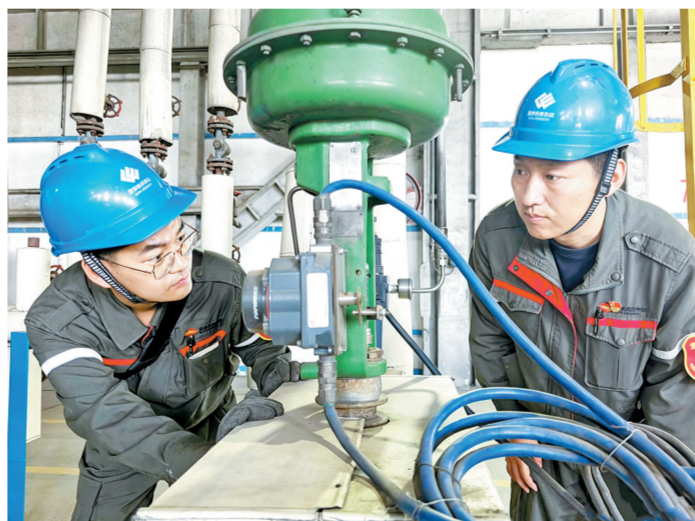
赵宁（左）、吕绍阔现场确认阀门实际开度。
