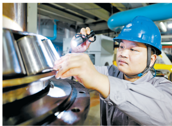
↑5月28日,河北公司定州电厂维护人员检查磨煤机磨辊轴承。该厂强化设备全周期运维管理,紧抓负荷低谷停备窗口期,统筹开展制粉系统隐患排查与缺陷专项治理。通过精细化管控补齐设备短板,持续提升设备运行状态,为机组安全稳定迎峰度夏保驾护航。
