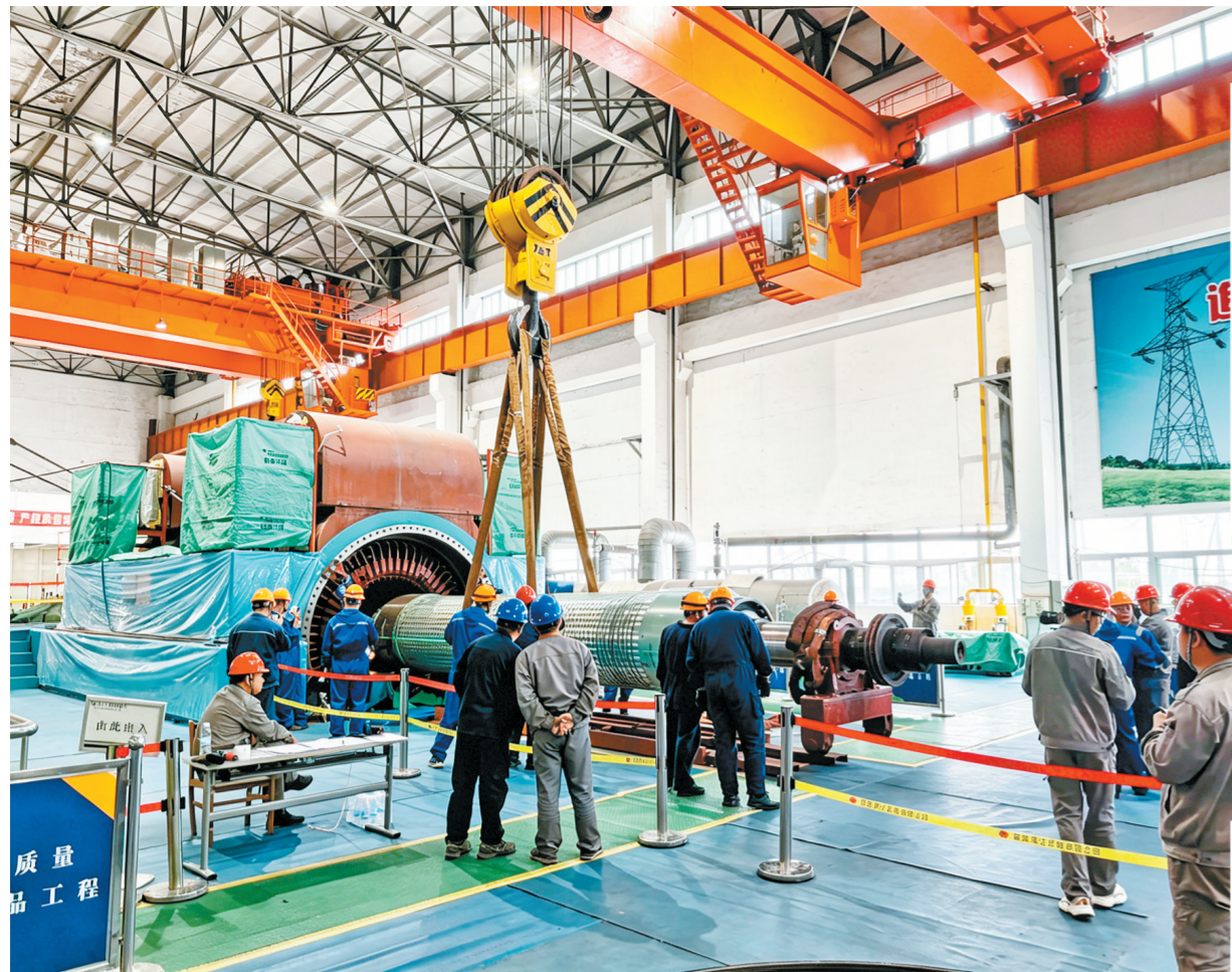
↑5月26日,吉林工程公司扎实推进检修现场标准化管理,在双辽公司4号机组A级检修现场,发电机转子抽出关键工序紧张有序开展。现场严格落实人员定岗分工机制,技术、起重、安全监护各岗位人员密切协同,履职尽责,全程恪守标准化作业流程,精准管控转子起吊、穿芯、移出等关键节点,以毫米级作业标准实现设备“零磕碰、零损伤”,依靠严谨的现场管理与工艺管控,为机组后续安全稳定运行筑牢坚实基础。
