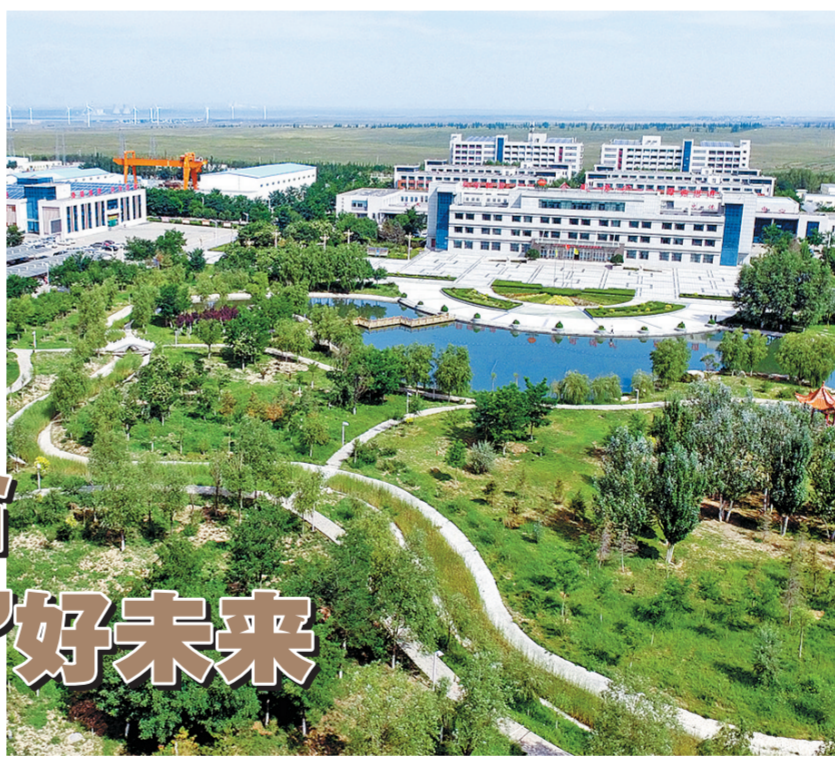
大图 宁夏煤业金凤矿全景图。 小图 宁夏煤业金凤矿智能化控制中心。
