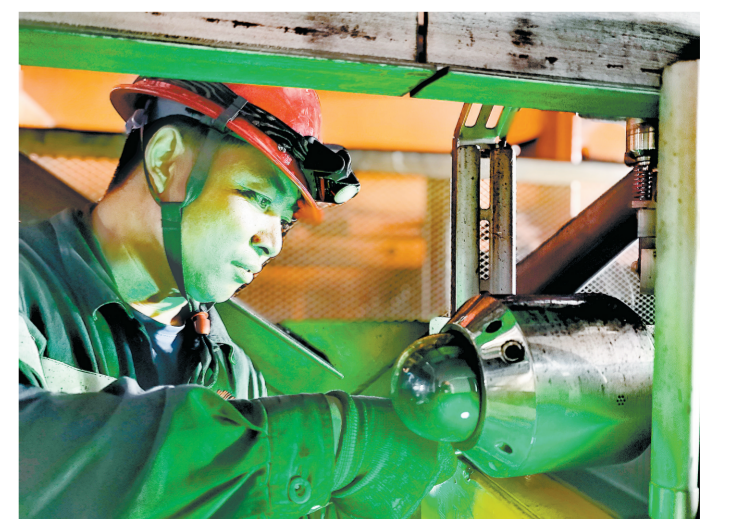
近日，雁宝能源运销公司从严从细抓实设备安全管理，常态化推进设备检修、维护与保养，精准排查整治隐患。该公司严格落实检修计划、标准化作业流程和包保责任制，加密巡检频次，对发现隐患实行闭环管理，全力保障设备安全平稳运行。图为5月23日，检修人员检修109皮带机巡检机器人。 本报通讯员 王坤 摄
