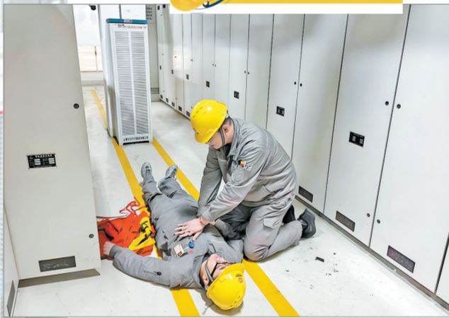
▲5月14日,吉林江南公司组织开展人身触电应急演练,以实景实操检验职工触电应急处置能力,切实提升职工应急响应和协同处置水平,确保企业安全生产稳定。图为运行人员在380V母线室进行心肺复苏演练。 本报通讯员 孙国峰 郭立彬 摄
