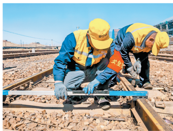
↑随着气温持续走高,线路胀轨跑道风险陡增,焦化铁路公司启动防胀专项检查整治工作,组织骨干力量对管内重点区段线路、道岔开展拉网式隐患排查,筑牢暑运安全防线,全力保障列车安全平稳运行。图为5月18日,线路工调整绝缘连接扣件。 本报通讯员 杨梓 摄
