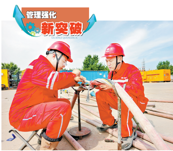
今年以来,准能黑岱沟露天煤矿将修旧利废作为降本增效的重要抓手,引导员工树立惜旧如新的节约观念,让出现故障的电缆连接组件、供电设备等重新投入投入使用。截至目前,通过拆解组合、新旧搭配、零件制作等手段,已累计修复或重组电缆插头总成及耦合器共32个、电缆分支箱2个、地理电缆300米,节约成本28.3万元。图为5月12日,维修电工修复电缆接线。 本报特约记者 向南 摄
