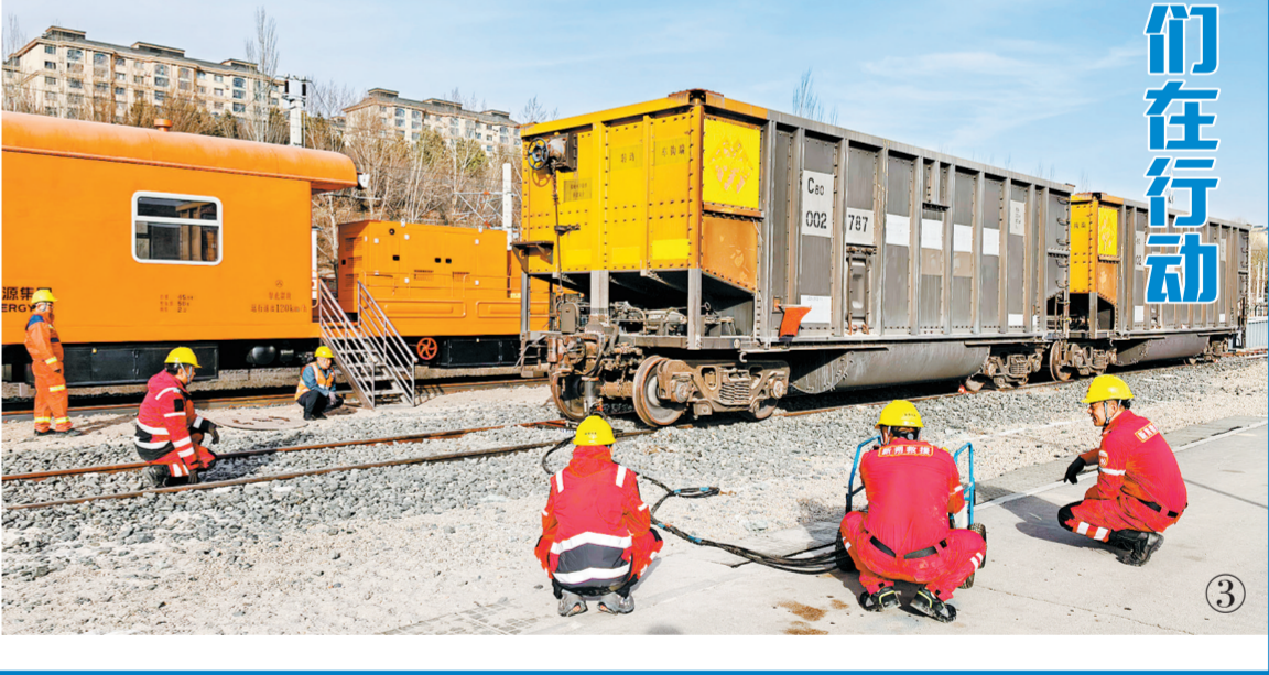
③5月12日,新朔铁路机务公司应急救援队开展轨道救援演练,规范操作救援设备,强化协同处置能力,筑牢运输安全防线。图为演练现场。 本报通讯员 张德惠 摄
