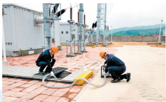
5月8日,龙源电力吉林公司宏升场站工作人员排查电缆沟并抽取积水。 本报通讯员 刁目国 摄
