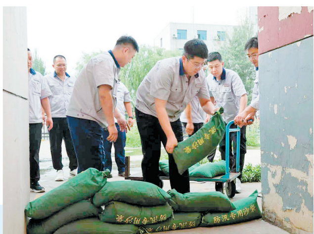
5月12日,铁路装备榆林分公司开展防汛应急专项演练,演习人员堆砌沙袋加固防护。 本报通讯员 苏伟 马燕平 摄
