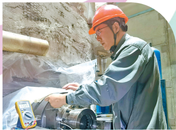
周旭检测安装小汽轮机给水泵轴振探头。
