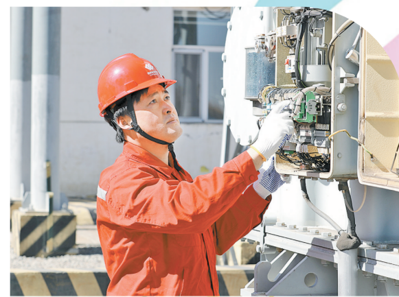
闫慧宁调试主变压器控制回路。
