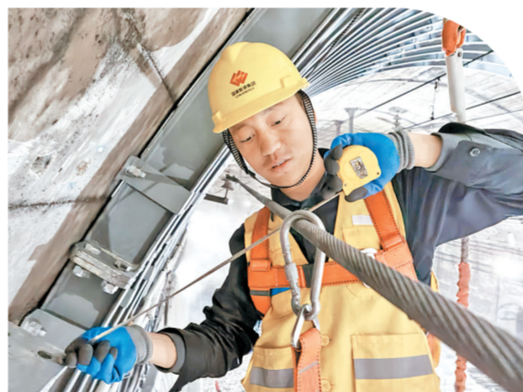
牛卫东在隧道内测量接触网磨耗。
