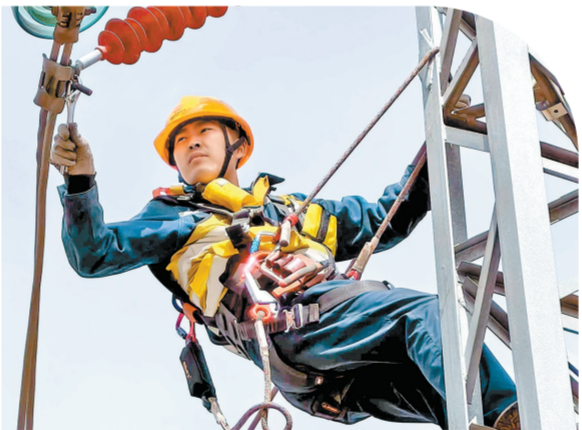
冯明亮更换附加导线绝缘子。
