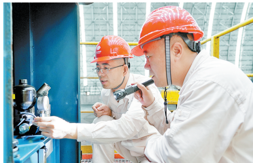
⑥ 5月3日,广西北海公司技术人员检查斗轮机液压系统电磁阀紧固情况。 本报通讯员 王懋霖 摄
