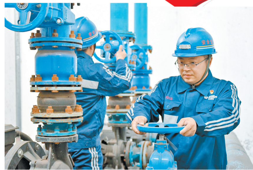
今年以来,平庄矿业六家矿党委持续深化“六型”党支部创建活动,强化党建带工团、党小组带班组、党员带群众,不断提升党建工作质效,全面增强党组织的凝聚力向心力,为能源稳定供应奠定坚实基础。图为4月20日,检修工点检污水处理站煤泥泵。 本报通讯员 郭浩 摄
