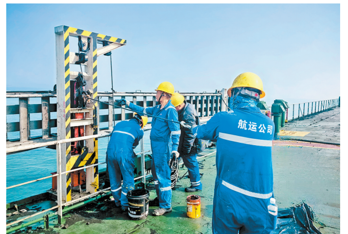
为深入推进船舶安全生产专项整治行动,“神华503”轮扎实开展设备例行自查。安全检查小组对舷梯、系泊设备等关键设施进行拉网式排查,精准排查出断丝隐患。船员规范有序完成旧绳拆除、新绳安装等关键工序,切实筑牢船舶设备安全防线。图为4月10日,船员更换舷梯钢丝绳。 本报通讯员 张涛摄
