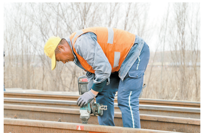
新朔铁路大准公司二道河站区春季集中修开展以来,工作人员紧盯施工管理、设备运用、作业安全等关键环节,采取“挂图作战”的方式,按照包保分片模式,强化大机清筛捣固、成段更换长轨条等重点施工任务管理,确保集中修高效推进。图为4月13日,大红城线桥工区线路工整修扣件。 本报通讯员 姚平平 摄
